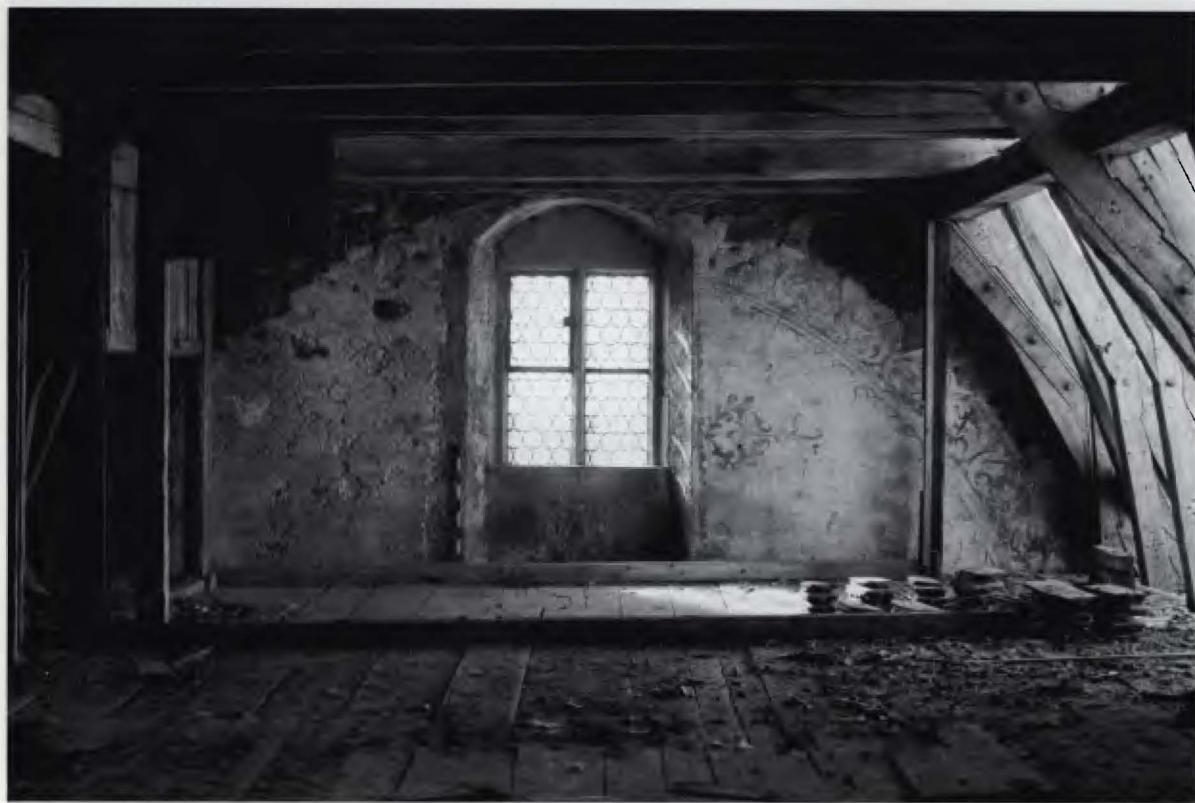
Abb. 10: Über der heutigen Mittelschiffdecke kann man im Dachboden an der Innenseite des Westgiebels Reste einer Malerei entdecken, die einst der hölzernen Rundtonne zugeordnet waren, die im 15. Jahrhundert eingebaut wurde und das Mittelschiff steil überspannte. –
