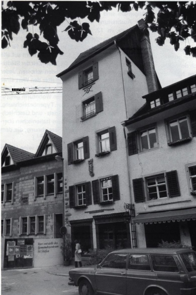
Haus "zur vorderen Katz" in Konstanz. Ursprünglich wohl Wehrturm, später Wohnturm.
