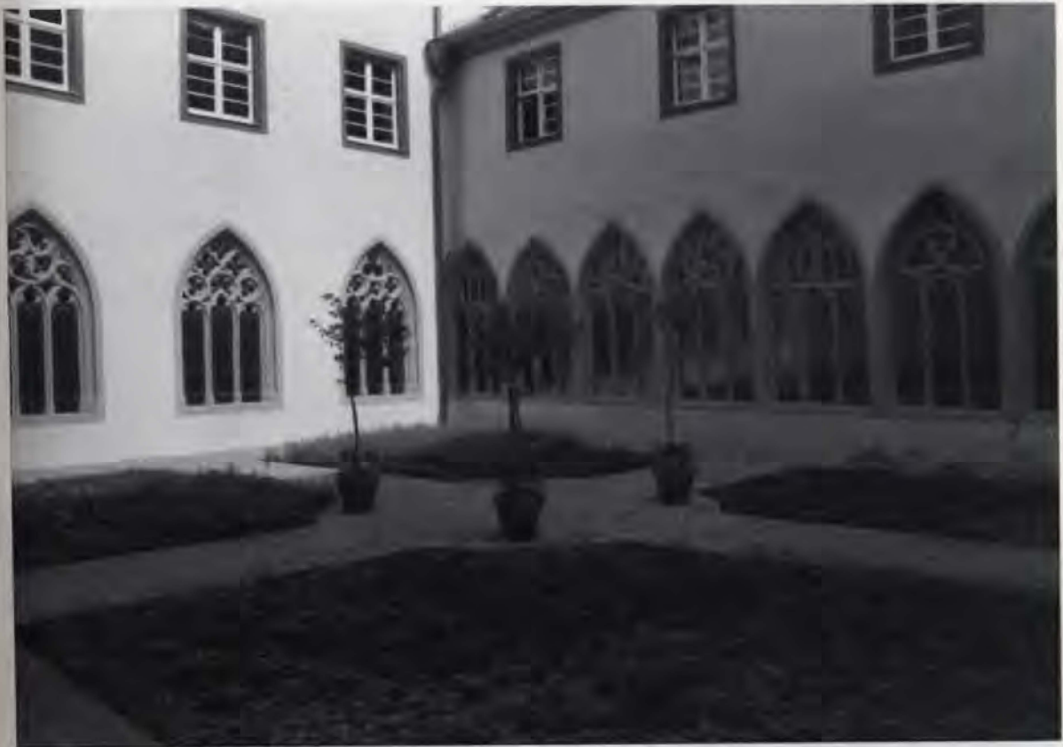
Blick in den Kreuzgang, dessen Fensteröffnungen aus heiztechnischen Gründen verglast werden mußten.
