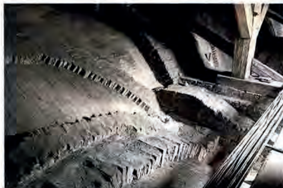
Foto 9 Ehem. Benediktinerkirche Villingen Ausschnitt Dachstuhl und Gewölbeaufsicht (Gurtbogen zwischen Langhaus und Chor)
