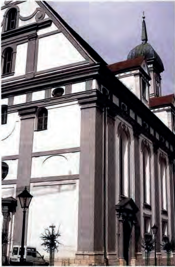
Foto 4 Studienkirche Dillingen, Fassaden von Südwesten
