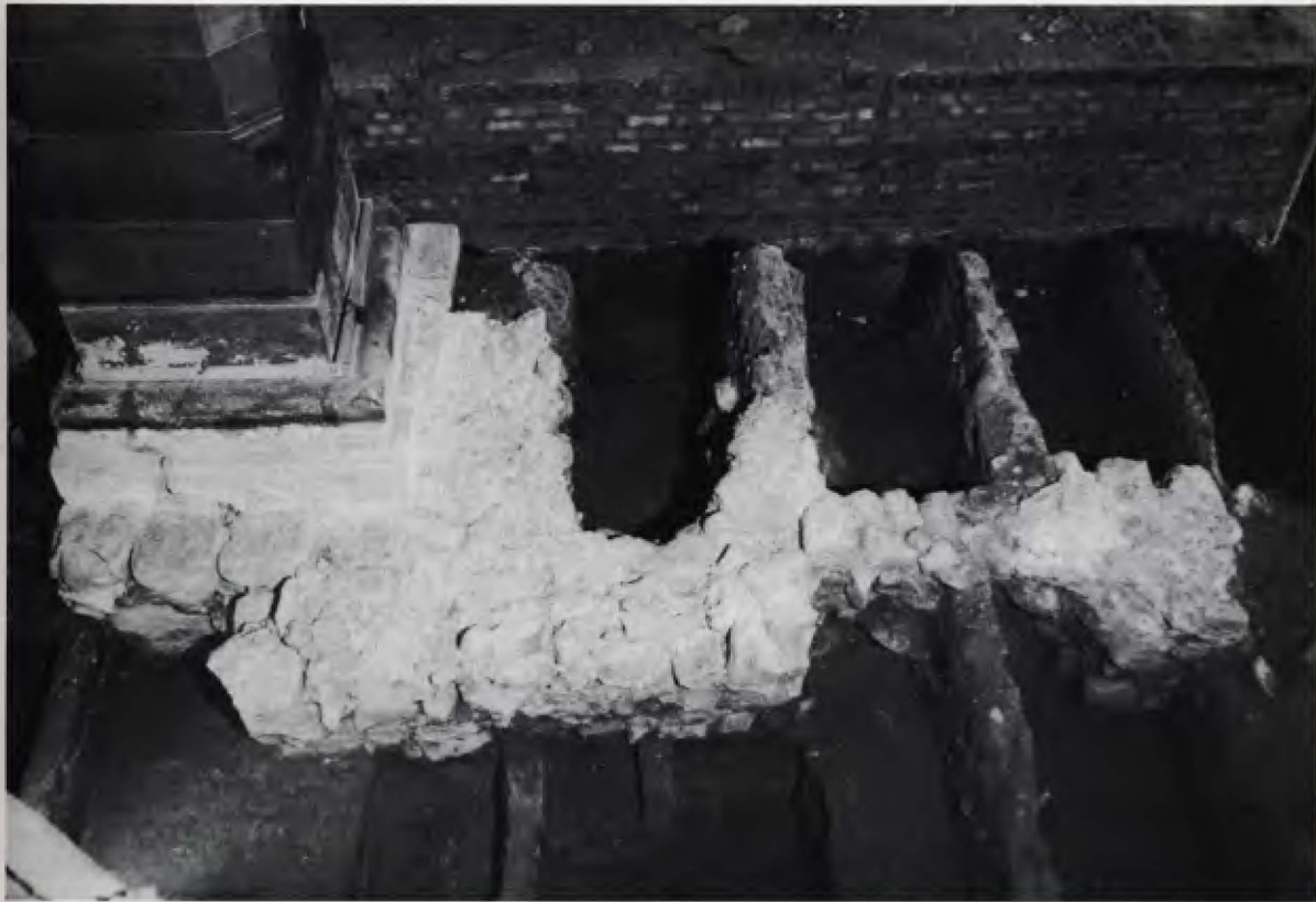
Abb. 3: Lage der Grabstätten westlich und östlich des alten Lettner-Fundamentes. Die östliche Gräberreihe wurde durch den modernen Heizkanal (Hintergrund) angeschnitten.
