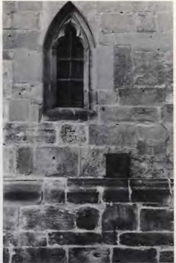
An der äußeren Südwand des Südturms befindet sich in Augenhöhe ein Eisentürchen zum Seilende der Sturmglocke.
