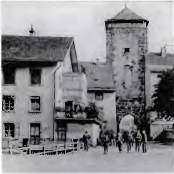
Das Foto aus dem Jahre 1913 zeigt die Tormühle. In dem niederen Vorbau befand sich die Radkammer, über den damals noch offenen Sägebach. Die Fußgänger-Durchbrüche beim Riettor entstanden erst 1924.
