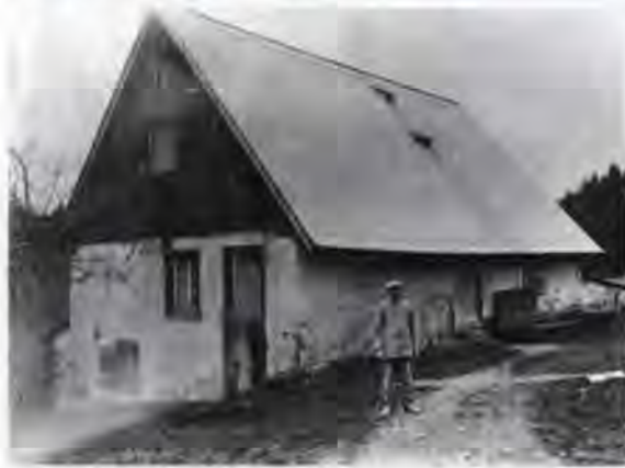
Zwei Fotos von der ehemaligen Rindenmühle. Auf dem oberen Bild sieht man an den Dachluken einen Seilzug zum Antrieb landwirtschaftlicher Geräte im Ökonomiegebäude.
