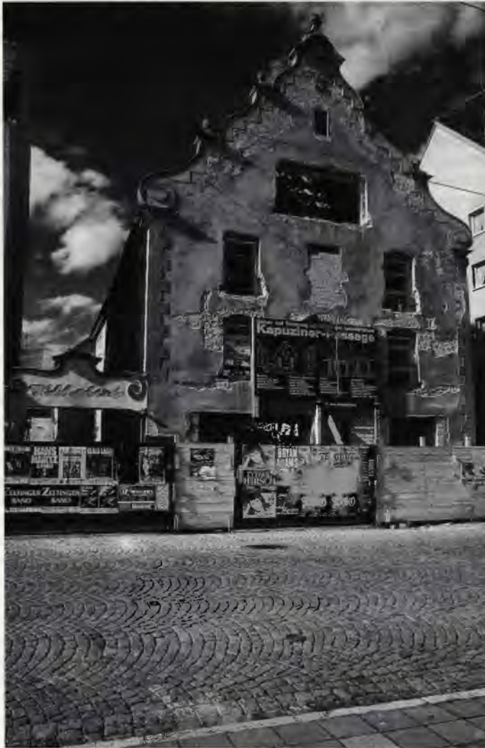
Giebel des Wohn- und Geschäftshauses Niedere Straße 88 zu Beginn des Umbaus 1987. Hinter der Fassade befand sich bis zum Jahre 1820 der Kirchensaal des Kapuzinerklosters.
