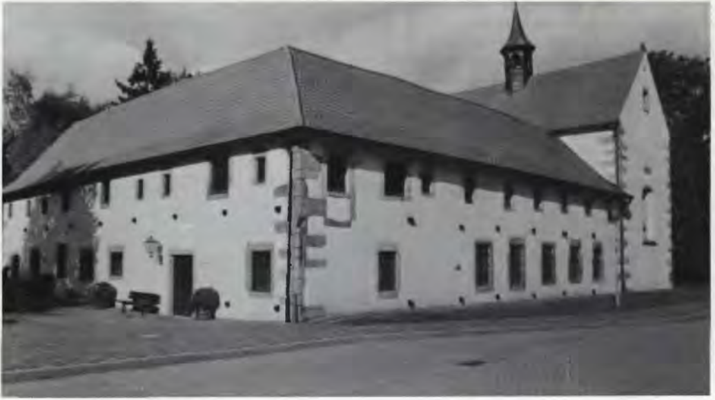
Der Klosterbau der Haslacher Anlage nach seiner Restaurierung. Vom Chor der Kirche, nach links wegführend, der Südflügel mit Refektorium und Küche im Erdgeschoß und den Zellen im Obergeschoß. Im Westflügel, der nach hinten abbiegt, befanden sich im OG Zellen, im EG weitere Funktionsräume. (siehe Text) Genauso hat man sich die Villinger Anlage vorzustellen, sie lag lediglich auf der entgegengesetzten Seite der Kirche.
