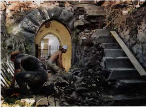
*Am 20. August 1993 wurde die vorhandene Betontreppe von der Firma Bisswurm teilweise abgestemmt.*
