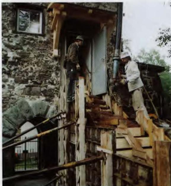
Am 27. August 1993 wurde die neue Betontreppe mit Zwischenpodest von der Firma Bisswurm betoniert. Roter Ölschieferzement und Porphyrschlackmaterial kamen zur Ausführung.
