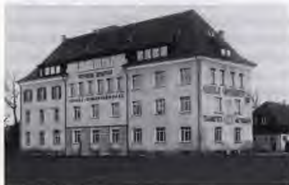
Kienzle Werksgebäude (1925) in der Prinz-Eugen-Straße (am Eisweiher).
