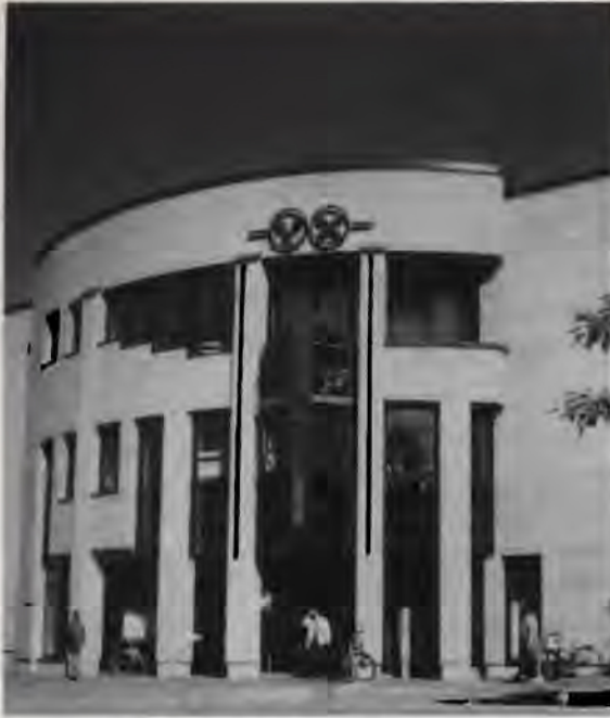
Das Hauptgeschäft der Volksbank eG Villingen am Rieter. Das Bankgebäude wurde im Januar 1985 bezogen, nachdem das ehemalige Zentralkaufhaus (ZK) von Grund auf umgebaut und neu gestaltet worden war.
