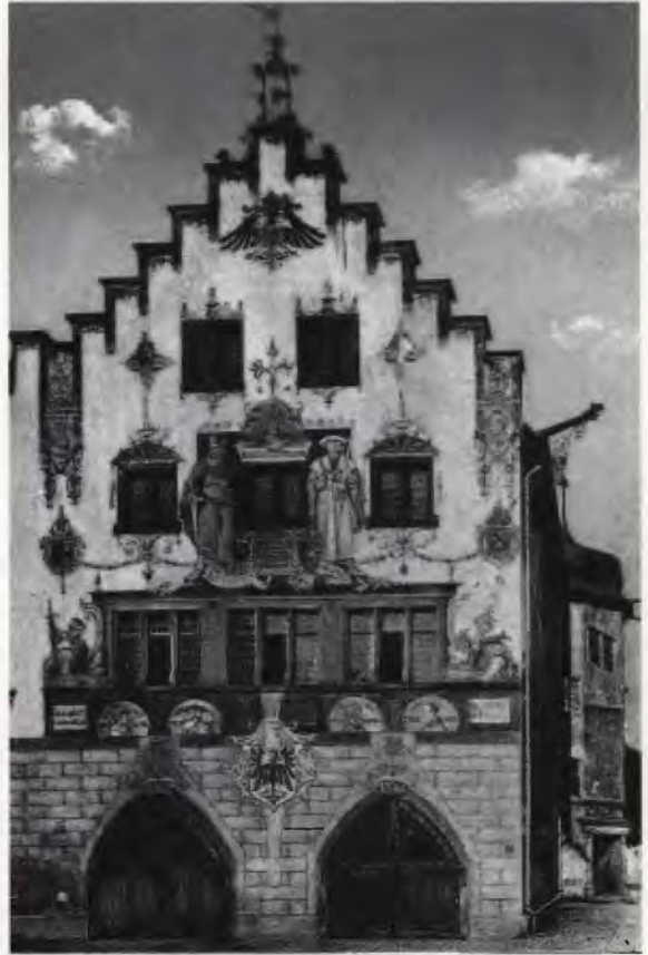
Abgewandelte Ausführung. Durch Witterungseinflüsse war sie bereits nach 2 Jahrzehnten so beschädigt, daß man sie wieder „übermalt“ hat. Heutige Optik der Rathaus-Fassade siehe Bild auf Seite 24 in diesem Heft.
