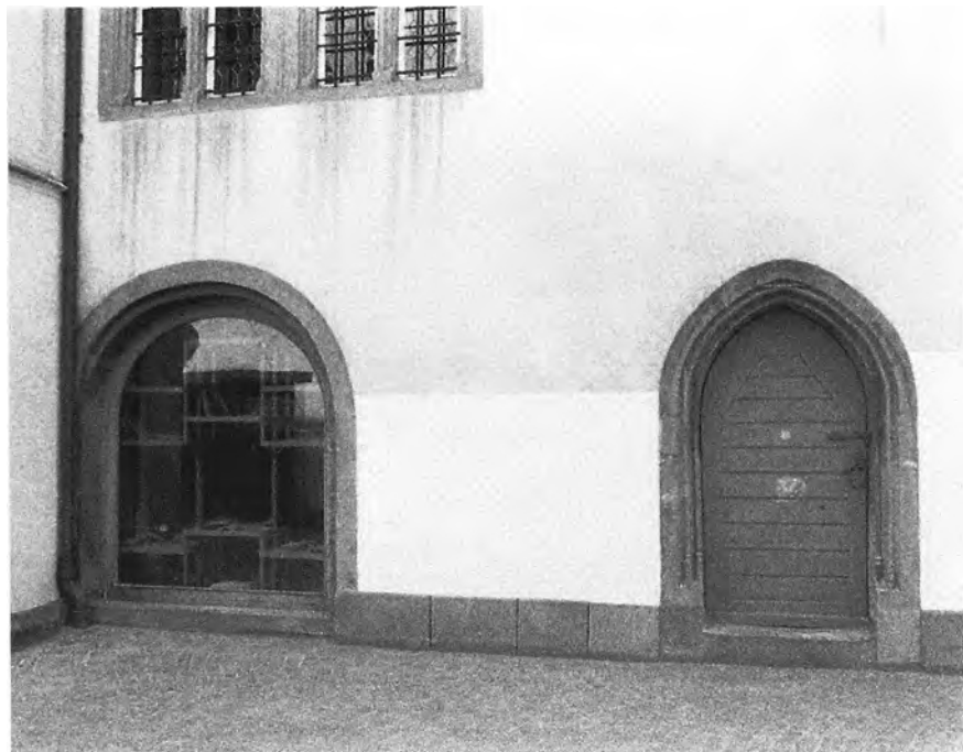
Der Torbogen (links) könnte in die Bauphase um 1341 gehören und eine Zufahrt für die Beschickung des Mittelbaus von der Rathausgasse her darstellen. Die spitzbogige Tür (rechts) gehört mit ihrer gegliederten Türfüllung zum Westbau und ist bei dessen Umbau um das Jahr 1511 entstanden.
