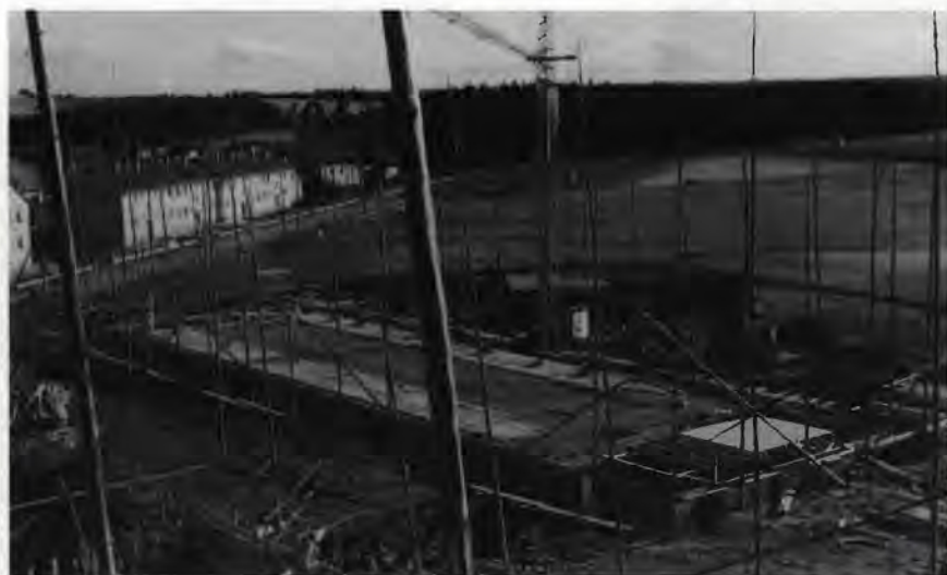
Die Baugrube im Herbst 1956, im Hintergrund das alte Konradskirchlein
