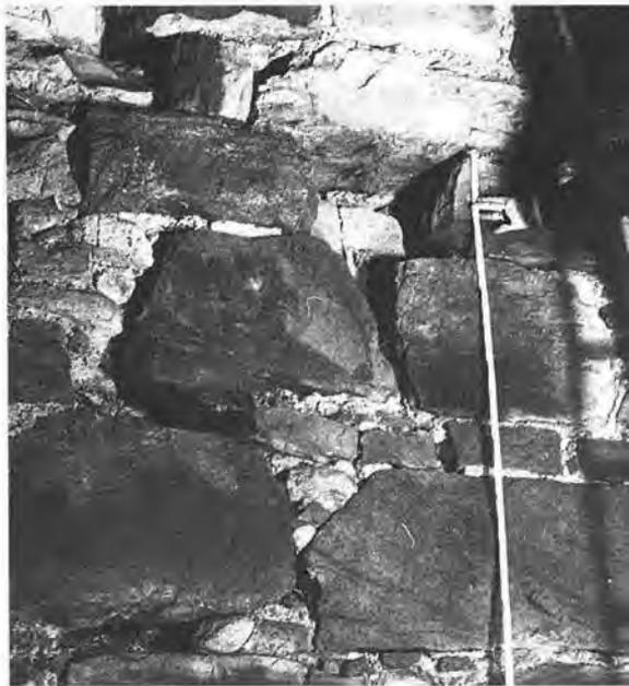
*Die Fugenlöcher im Mörtel der inneren Nordwand des Romäusturmes ab der Sohle, die offensichtlich herausgearbeitet wurden, verraten einen Bereich, innerhalb dessen ein Aufstieg bis zur Höhe von etwa 4,60 m ohne große Anstrengung möglich (gewesen) wäre. Im Bild die Zone zwischen Höhenmeter 2 ab Sohle bis 4 Meter.*
