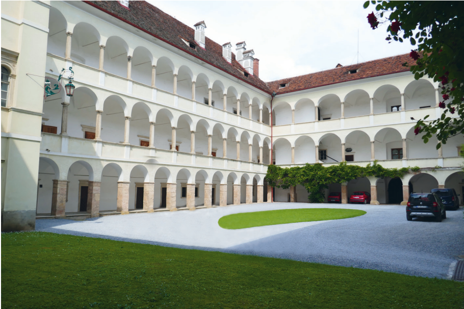
Abb. 2: Innenhof des Schlosses Thannhausen, 2018. Aufnahme: Verfasser.
