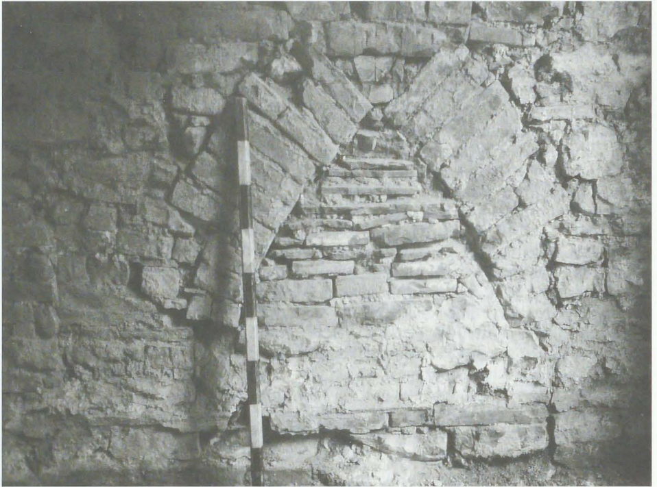
Abb. 6: Spätmittelalterliches „Fenster“ im Gebäude 1
