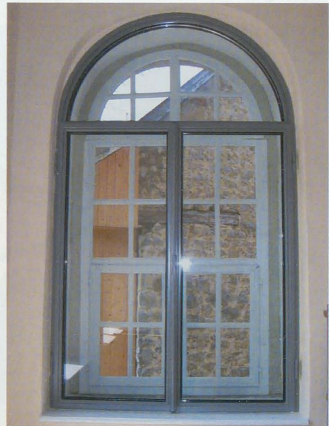
Abb. 3: Ergänzungen an einem originalen Fenster. Abb. 4: Ausbau des einfach verglasten Fensters zum Kastenfenster durch Einbau eines isolierverglasten Stahlrahmenfensters. Fenstersituation im Endzustand.
