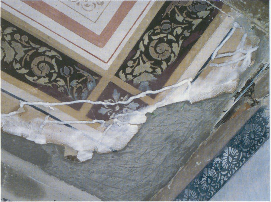
Abb. 10: Detail Decke Zwischenzustand 2008, Sicherung des Putz- und Maleribestandes durch Injektionsmörtel und Schließen eines entstanden Deckenverlustes durch ein Kalkputzsystem.
