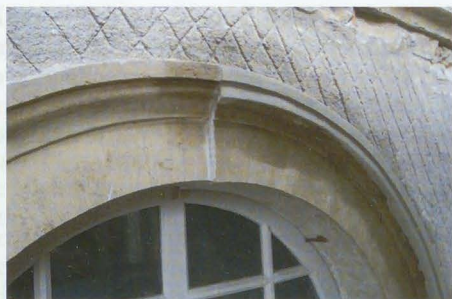
Abb. 5 u. 6: Eines der Fenstergewände aus (vermutlich) Weiler Sandstein mit abgewitterter Profilierung im Vor- und Zwischenzustand. Nach der Stabilisierung der entfestigten Bereiche wurden Fehlstellen mit einem Restauriermörtel ergänzt.
