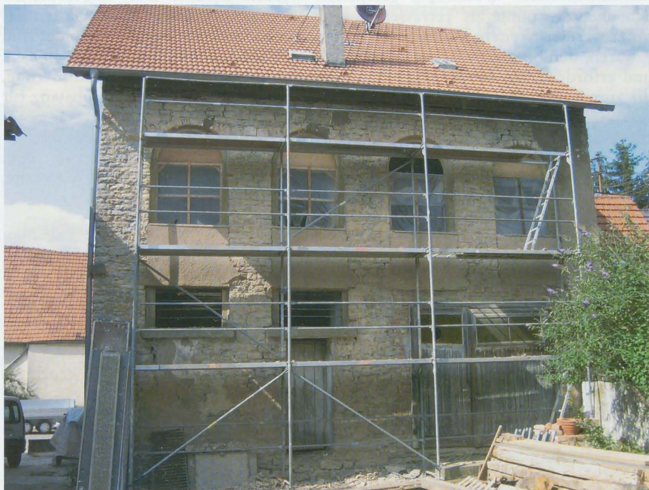
Abb. 2: Südfassade im Jahr 2005 während der Bauphase. Deutlich sichtbare spätere Eingriffe in die Wand. Nach Einzug einer Zwischendecke wurden die Fensteröffnungen teilweise vermauert. Tür und Scheunentor wurden ebenfalls in Umnutzungsphasen eingebrochen.
