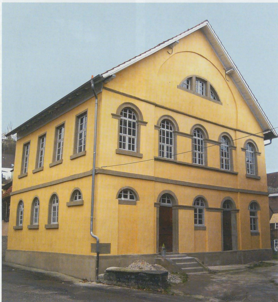
Abb. 7: Ansicht der ehemaligen Synagoge Rohrbach von Nord-Westen 2009
