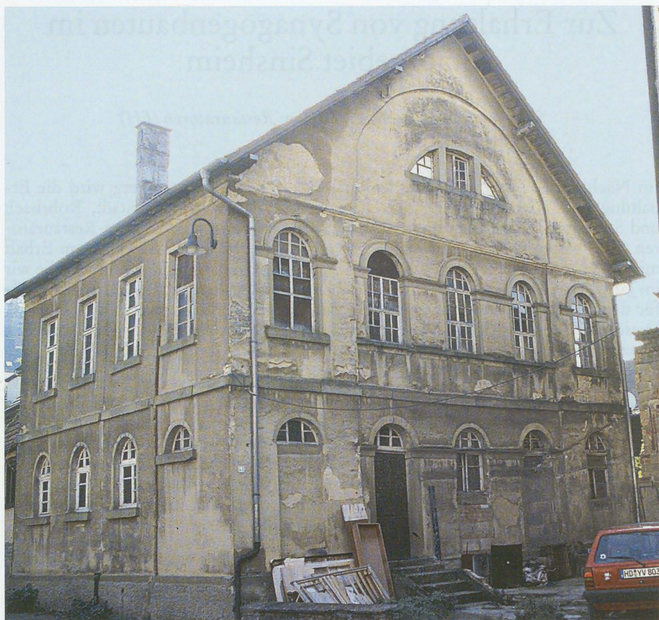
Abb. 1: Ehemalige Synagoge Sinsheim-Rohrbach. Ansicht von Nord-Westen. Aufnahme Frühjahr 2004.
