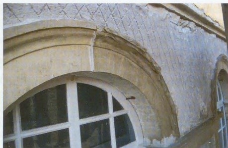
Abb. 5 u. 6: Eines der Fenstergewände aus (vermutlich) Weiler Sandstein mit abgewitterter Profilierung im Vor- und Zwischenzustand. Nach der Stabilisierung der entfestigten Bereiche wurden Fehlstellen mit einem Restauriermörtel ergänzt.
