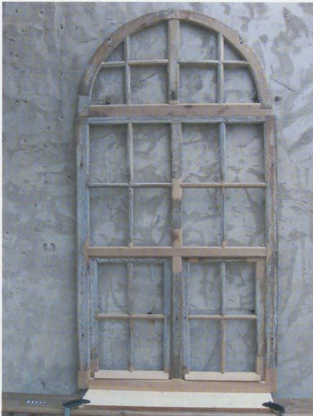
Abb. 3: Ergänzungen an einem originalen Fenster. Abb. 4: Ausbau des einfach verglasten Fensters zum Kastenfenster durch Einbau eines isolierverglasten Stahlrahmenfensters. Fenstersituation im Endzustand.
