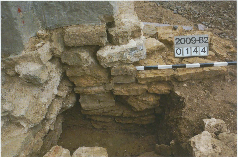
Abb. 3: Sinsheim, Stiftskirche. Fundamentbereich des südwestlichen Vierungspfeilers. Blick nach Ost. Deutlich ist zu erkennen, wie das von rechts (d.h. Süden) kommende Spannfundament aus der Hauptbauphase I stumpf gegen einen älteren Mauerzug heranzieht. Auf den Schnittpunkt der beiden Mauern wurde in einer jüngeren Maßnahme innerhalb der Phase 1 der Vierungspfeiler aufgemauert.
