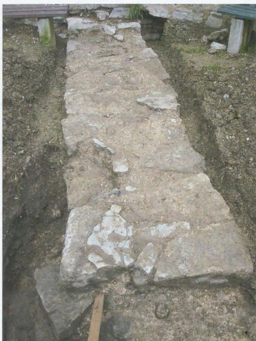
Das von Arens ergrabene Fundament eines Vorbaus an der Palas-nordwand. Es erstreckt sich von dieser 4,45 m im rechten Winkel nach Norden und trifft auf das Fundament der früher vom Steinhäus her kommenden Mauer oder Mauerplanung (Abb. 16.4).
