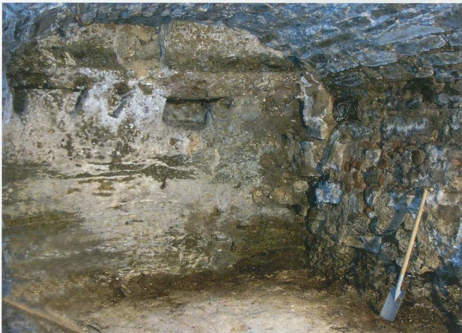
*Abb. 3: Die unvermauerte Stirnwand des Gewölbekellers vor Ausgrabung der historischen Verfüllung. Rechts die als Kellerwand genutzte, wahrscheinlich stauische Fundamentmauer.*
