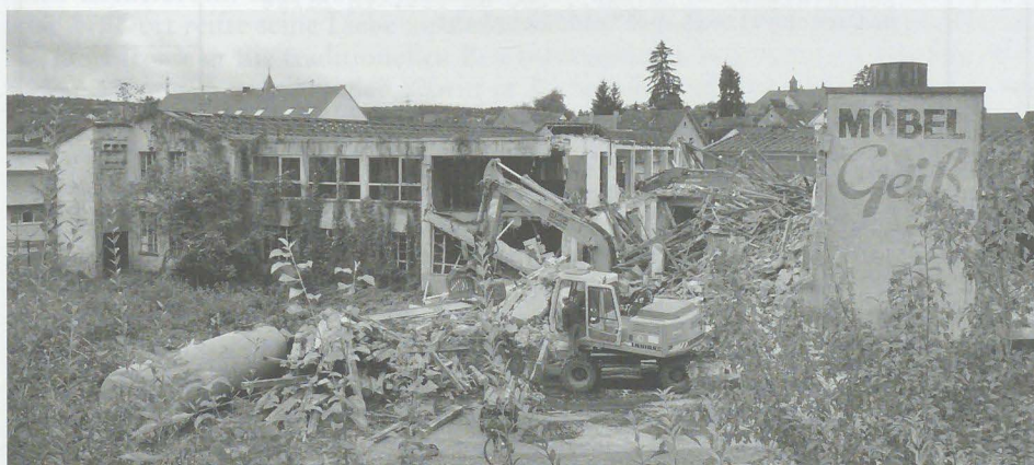
Abb. 5: Abriss der ehemaligen Produktions- und Ausstellungsräume der Firma Geiß an der Bahnhofstraße im September 2009.
