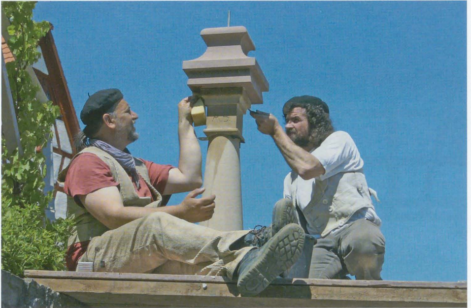
Die ehrenamtlich arbeitenden Fachleute Volker Bender (Steinmetz) und Jürgen Treffinger (Mauerrestaurator) beim Ausfugen.
