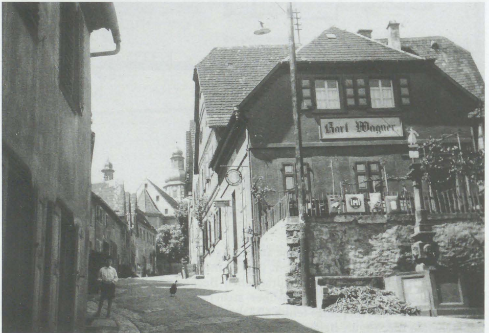
Der Lambrunnen am damaligen Haus Wagner, ca. 1938.
