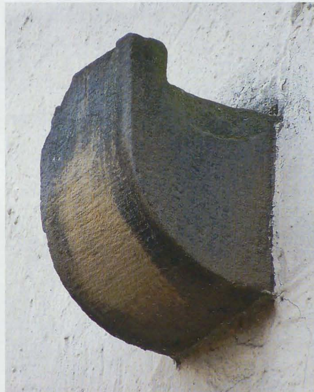
Abb. 15: Hakenkonsole auf der Nordseite des Kirchenschiffs
