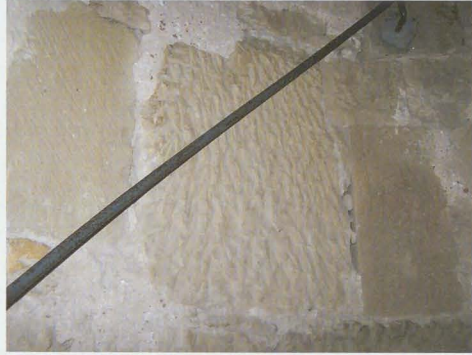
Abb. 9: Treppenaufgang im Turm; deutliche Unterschiede in der Oberflächenbearbeitung der Steine weisen auf die Verwendung von Spolien hin; links und rechts sind fein geflächte Werksteine erkennbar, wie sie in Bauphase II vorkommen
