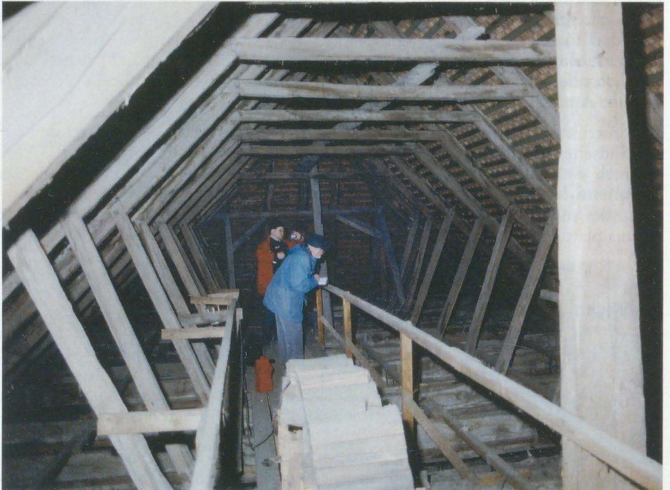
Abb. 10: Spätromanischer Dachstuhl der Klosterkirche Sinsheim
