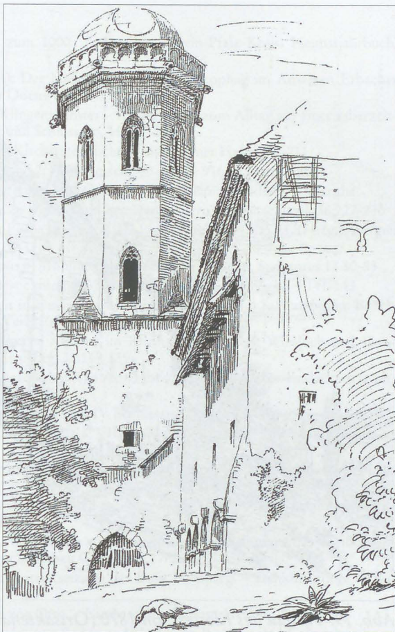
Abb. 18: Turm und Südfront im Jahre 1870 (Ortsaktenarchiv LDA Karlsruhe)
