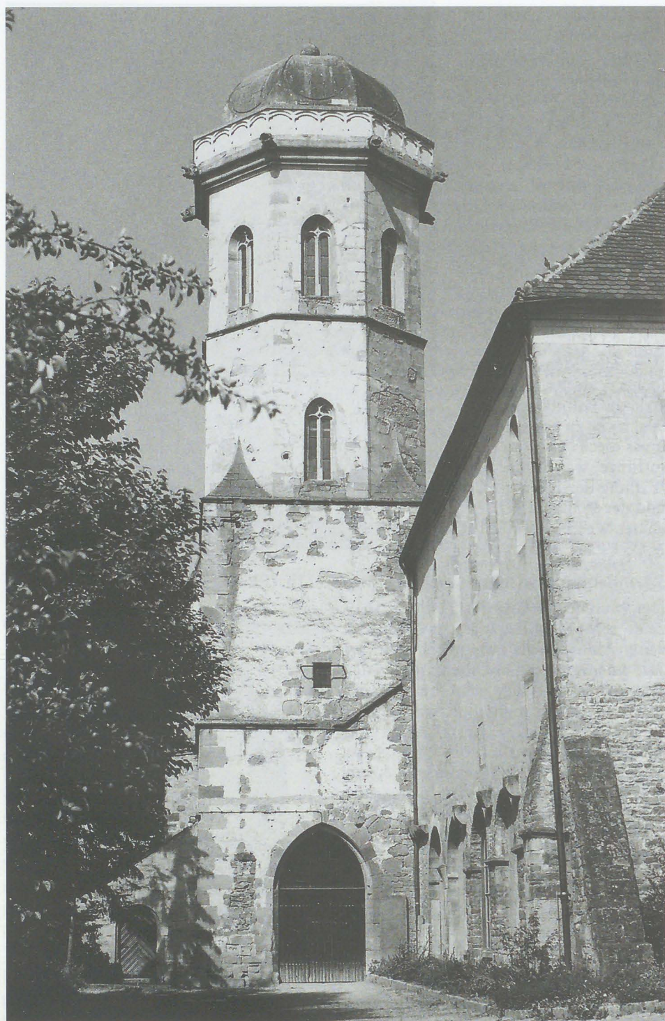
Abb. 16: Ostansicht des Turmes; Foto P. Marzolff 1958
