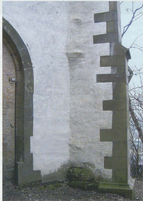
Abb. 12: Nordwestecke des Turmes mit älteren Bauresten, evtl. der 1630 abgerissenen Laienkirche von 1100
