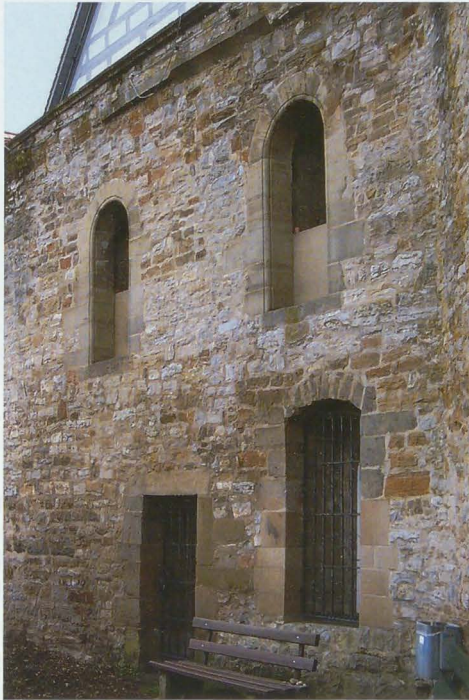
Abb 21: Vier romanische Türen in der Nordmauer des Palas, die vermutlich zu hölzernen Außentreppen führten)
