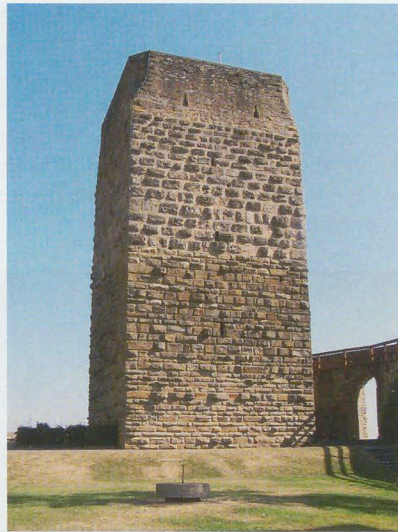
Abb 1: Roter Turm, Ansicht von Süden.
