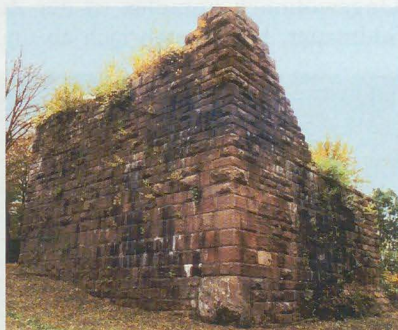
Abb 2: Der Bergfriedstumpf der „Mittelburg“ Eberbach besitzt, wie der Rote Turm, Buckelquader des älteren Typs.
