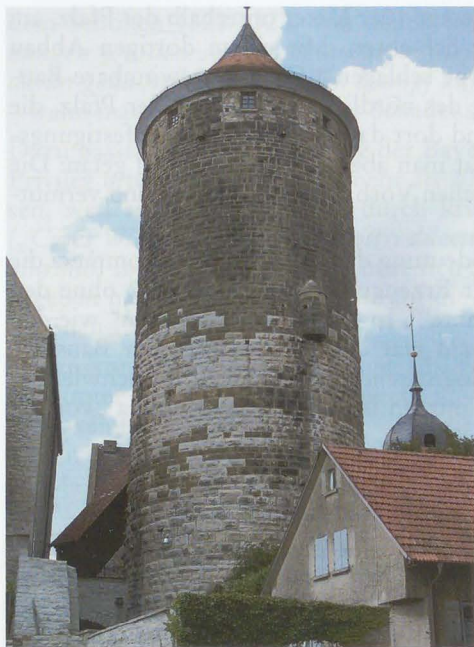
Abb. 27: Oberer Bergfried der Burg Besigheim; das untere Drittel ist mit Travertin-Buckelquadern verkleidet, der mittlere Bereich mit Kissenquadern aus Travertin oder Sandstein und der obere Abschnitt mit Sanstein-Kissenquadern.
