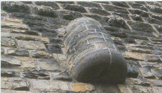
Abb. 4: Aborterker des Roten Turms aus dessen zweiter Bauphase.
