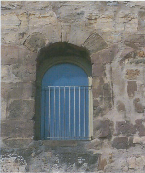
Abb. 6: Hocheingang des Blauen Turms mit Resten einer Nische; die Werksteine weisen Zangenlöcher auf, was eine Erbauung vor dem 13. Jh. ausschließt.
