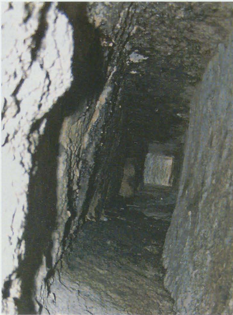
Abb. 10: Rauchabzug aus Tuffstein vom Kamin im ersten Obergeschoss des Torturmes.
