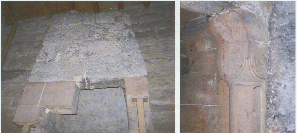
Abb. 3: Kamin des Roten Turms; links deutlich erkennbar der Materialwechsel innerhalb des Hutes; rechts Würfelkapitell der Kaminsäule.
