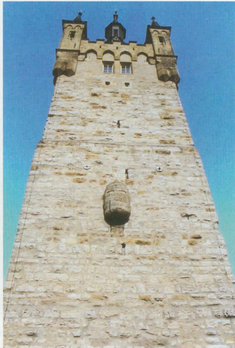
Abb. 5: Südseite des Blauen Turms mit baugleichem Aborterker wie am Roten Turm.
