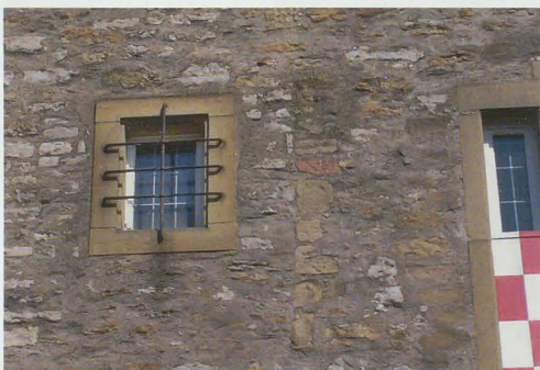
Abb. 17: Östliche Laibung einer früheren Öffnung im ersten Obergeschoss der Südseite des Steinhauses.
