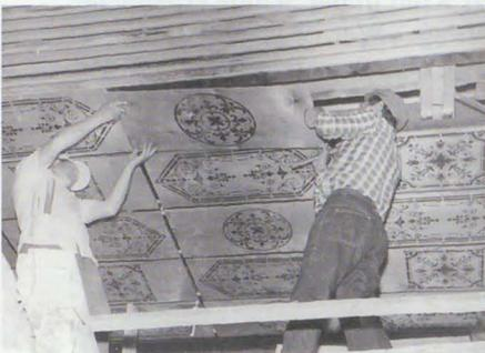
Montage von Metallplatten an der Decke
