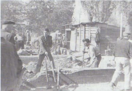
Abbruch von Altfundamenten für den Neubau
