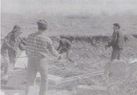
Moniereisen werden an einem Altbau ausgebaut
