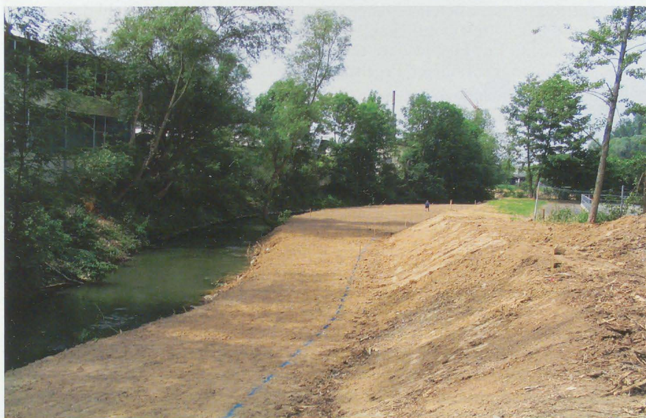
Bach-Aufweitung in Zuzenhausen
