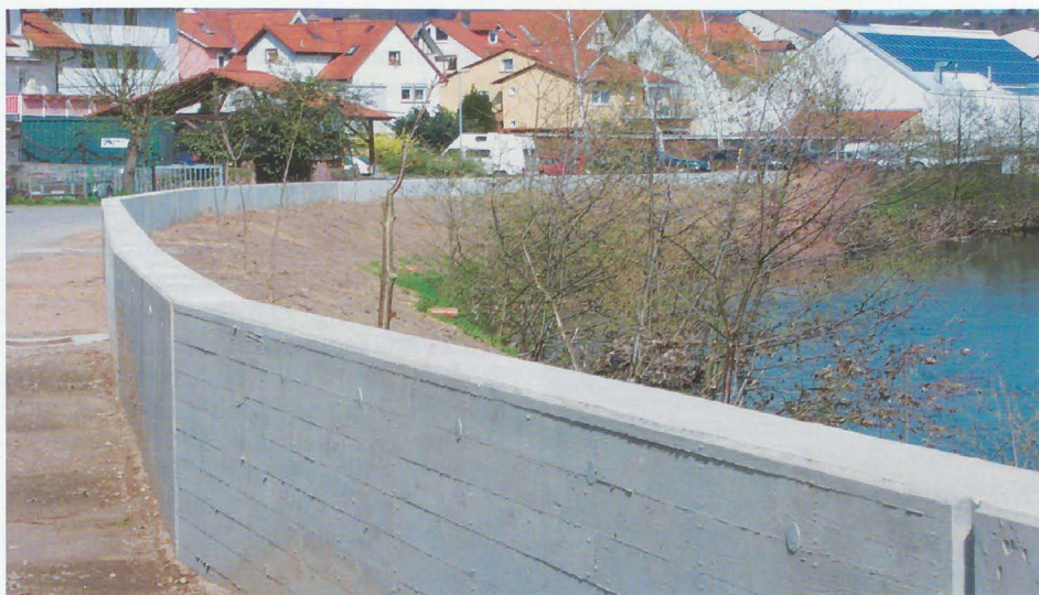
Ufermauer in Bammental
