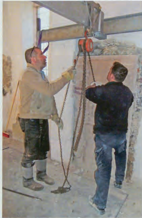
Abb. 9: Ausbau der Grabplatte der Helena von Eltz, gest. 1624.
