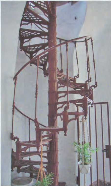
Die industriell gefertigte Wendeltreppe mit den Stufen aus Gußeisen
