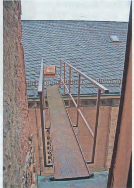
Der Stahlsteg, Übergang vom Turm zur Dachluke des Mittelschiffgewölbes
