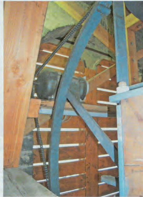
Läuterad, E-Motor mit Kettenritzel, Kette und Schallläden
