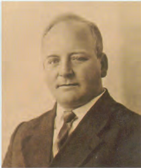
Auf dem Grundstück von Johannes Mangei wurde der Holzturm erstellt. Bildquelle: Alfons Mangei
