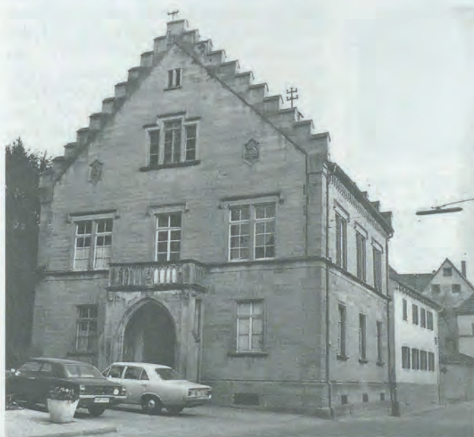
Abb. 1: Altes Rathaus, Ansicht von Norden. Landesdenkmalamt Karlsruhe Ortsakte Sulzfeld/KA
