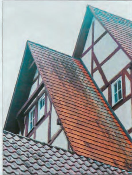
Im linken, niedrigeren Teil des Doppelgiebels auf der Südseite ist recht gut der Schwebegiebel zu erkennen.
