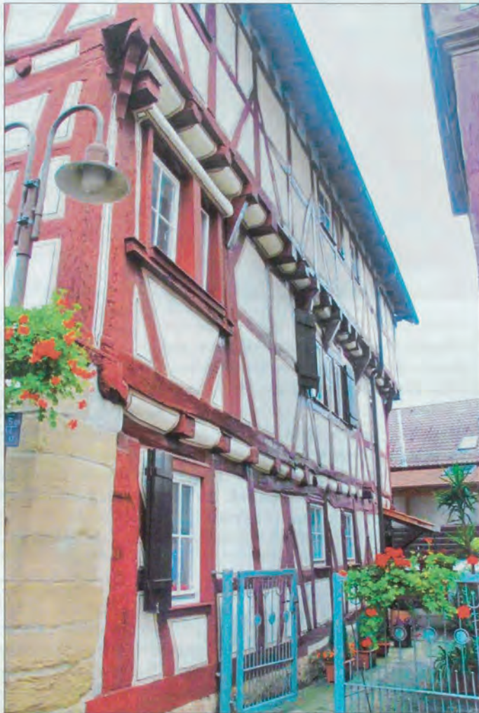
Blick von der Altstadtstraße auf die südliche Traufseite mit vorkragendem 1. und 2. Obergeschoss, ganz links im Bild im 1. OG alemannischer Fenstererker. Eine Eckknagge links vom Fenster und eine Knagge rechts stützen die vorkragenden Balken ab. Die Eckknagge ist als Konsole ausgebildet. Im Erdgeschoss ganz links die nachträglich angebrachte Sandsteinmauer.
