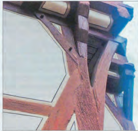
Südostecke: Detaill der Eckkonstruktion zwischen dem 1. und 2. OG.
