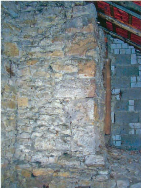
Burg Altwiesloch – Mauerecke
