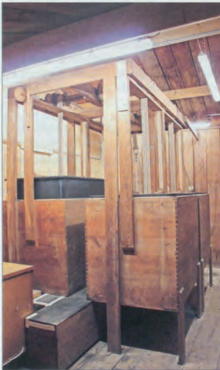
Abb. 4: Balgkammer auf dem Dachboden
