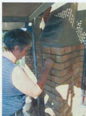
Bei der Restaurierung der Klinker.
