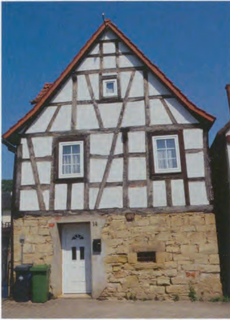
Abb. 6: Wohnhaus mit Schilfsandsteinerdgeschoss sowie Wohngeschoss und Giebel aus Fachwerk aus dem Jahr 1823 in der Luisenstr. 14
