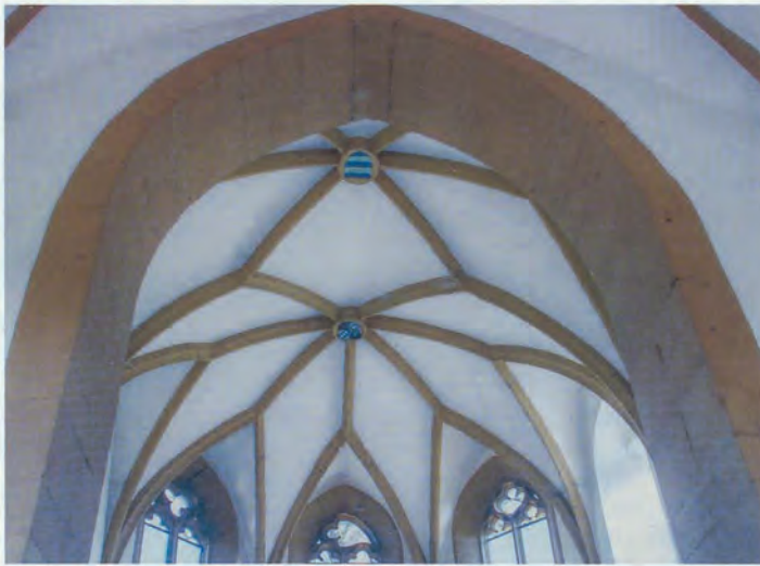
Abb. 6: Gewölbe des Chors der Ottilienkapelle.
