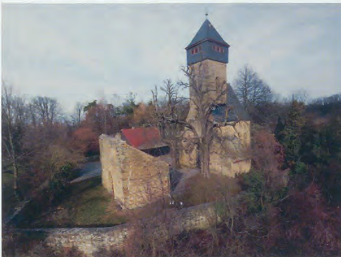
Abb.1: Die Ruine der Ottilienkapelle auf dem Ottilienberg bei Eppingen. Die Kapelle wurde von der Denkmalstiftung des Landes Baden-Württemberg „als Kulturdenkmal von besonderer Bedeutung“ zum Denkmal des Monats September 2015 erhoben.
