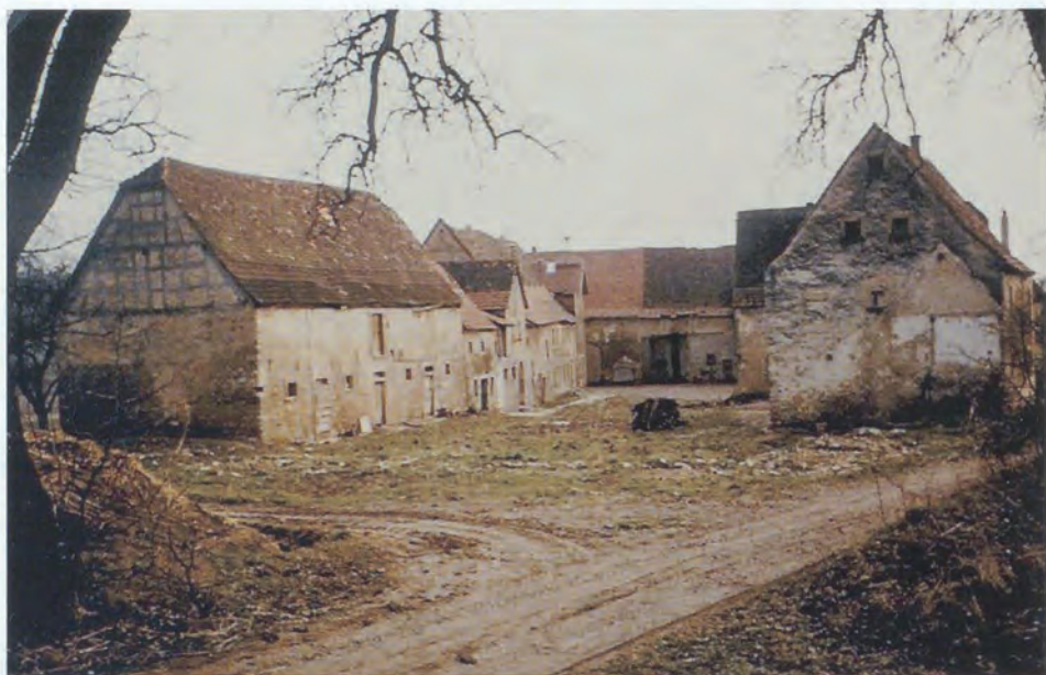
Teilansicht zerfallener Bausubstanz vor dem Abbruch.
