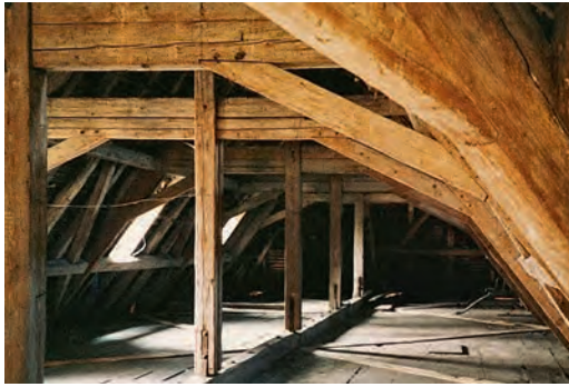
Dachstuhl mit Hängewerk vor dem Umbau (Foto H. Arnold)
