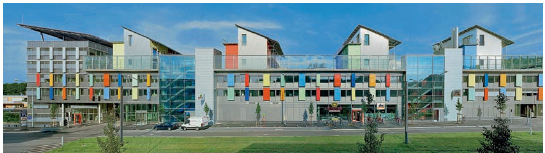
Das Sonnenschiff in Freiburg (Copyright: Rolf Disch SolarArchitektur)
