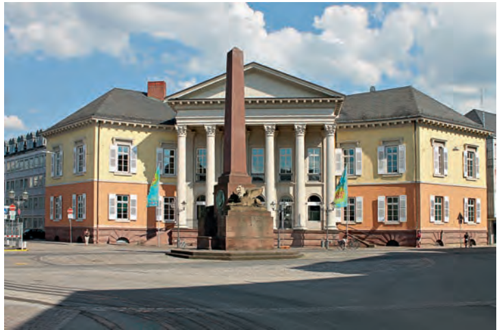
Blick auf die 1822 bis 1827 gebaute Verfassungssäule. (Foto: Michael Kohler)
