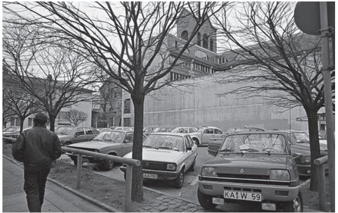
Im Oktober 1979 wurde das auf dem westlichen Teil des Ständehausareals errichtete katholische Dekanatszentrum eingeweiht. Der östliche Teil diente bis zum Bau des Neuen Ständehauses weiter als Parkplatz, 23. Januar 1988, StadtAK 8/BA Schlesiger A55_19_7_18.
