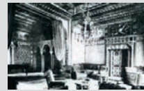
Herzstück des von dem Mannheimer Architekten Wilhelm Manchof entworfenen Anbaus war ein der Zeitmode folgender „Maurische Saal“.
