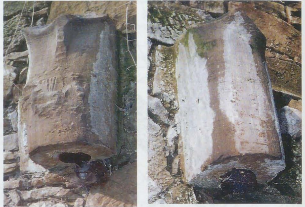
Abb. 5 a und b Widerlager für die Torangeln
