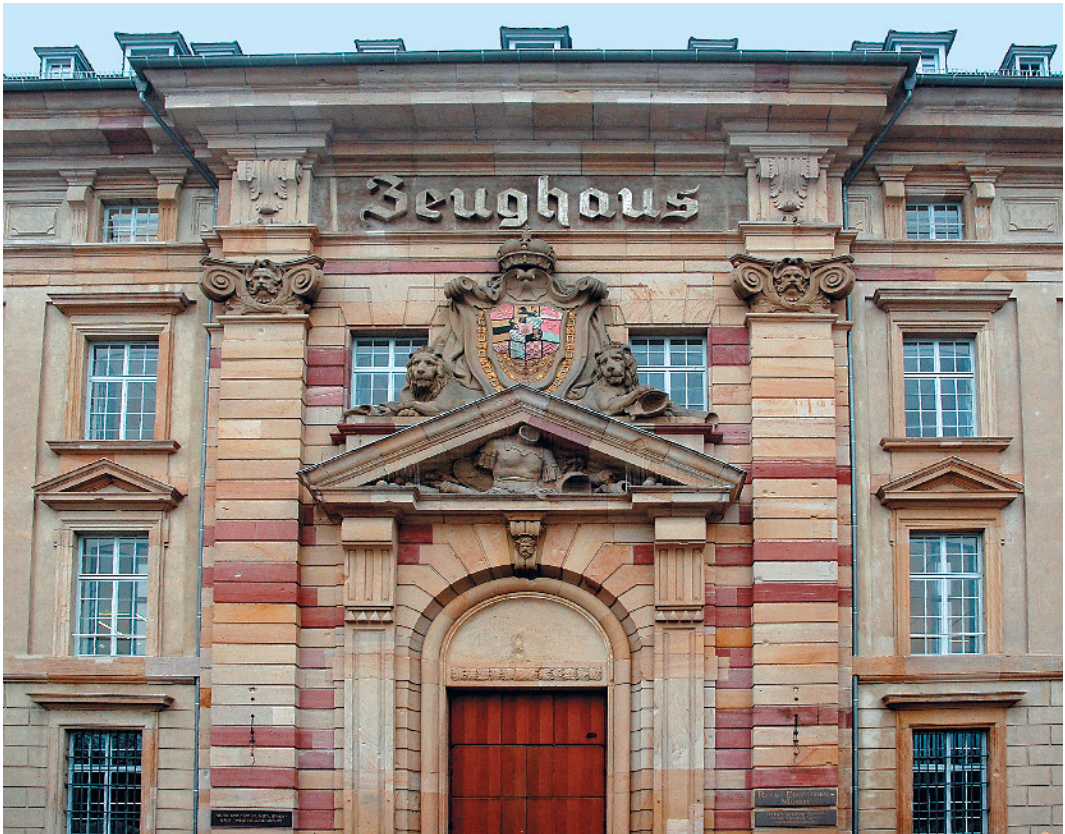
Detail Zeughaus Fassade, (rem. Jean Christen)
