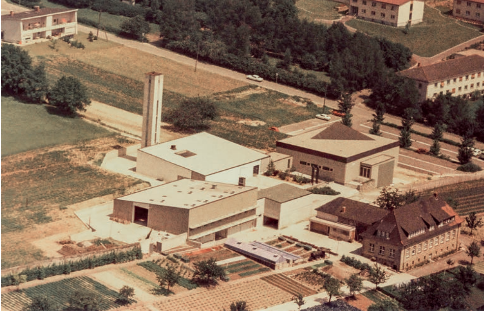
Kreispflegeanstalt in Blickrichtung Nordosten 1968
