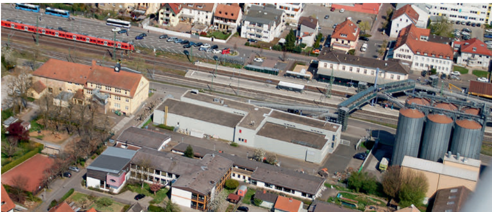
Jahnstraße, Bahnhof und Raiffeisen-Lagerhaus 2020
