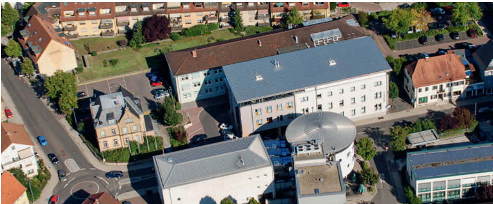
Wilhelmstraße, Ziegelgasse und Rathaus Sinsheim 2015
