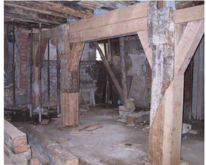
Bild links: Stützbalken vor der Ergänzung der Fehlstelle; die Stahlstütze ist noch teilweise sichtbar.
