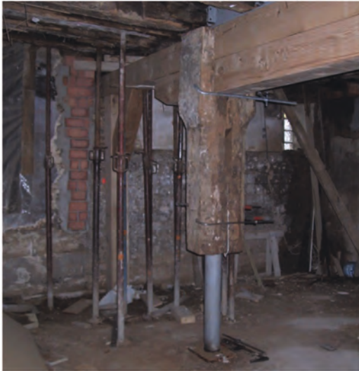
Bild links: Stützbalken vor der Ergänzung der Fehlstelle; die Stahlstütze ist noch teilweise sichtbar.
