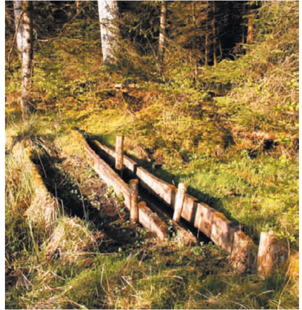
Beispiel einer Entwässerungssperre im Fördergebiet Plattenmoos.
