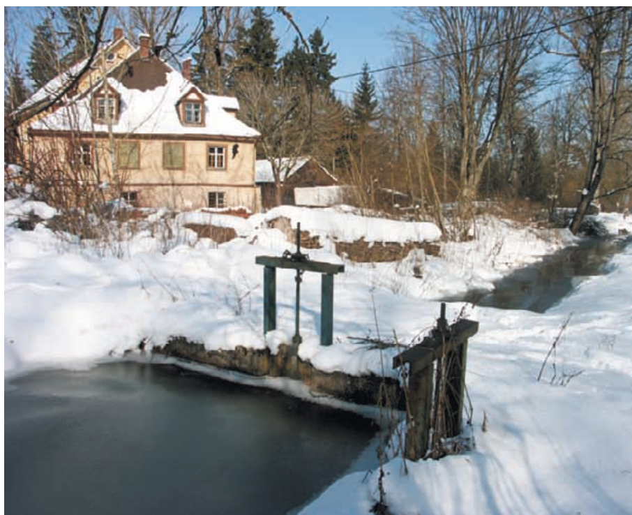
Zulaufkanal zur Eiswiese mit Stellwehr an der Graselli-Mühle. Foto: Hubert Mauz
