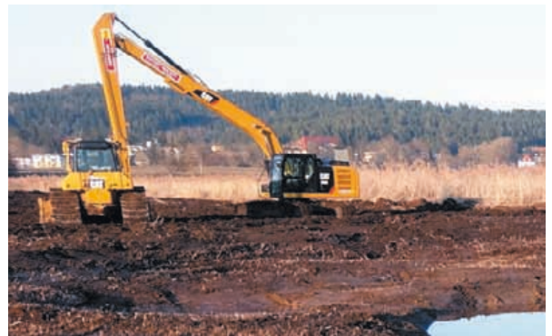
Langarmbagger und Spezialraupe im Einsatz. Foto: Hildegard Körner.
