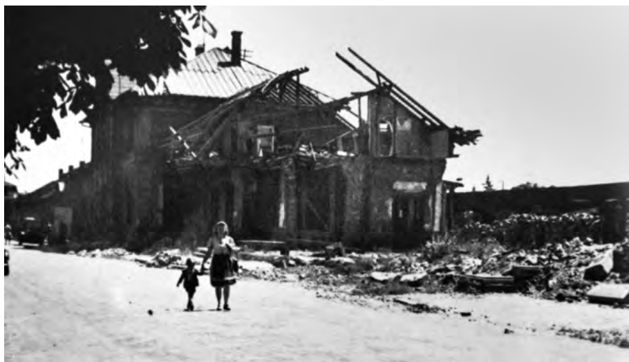
Der zerstörte Villingener Bahnhof. Foto: Stadtarchiv Villingen-Schwenningen.
