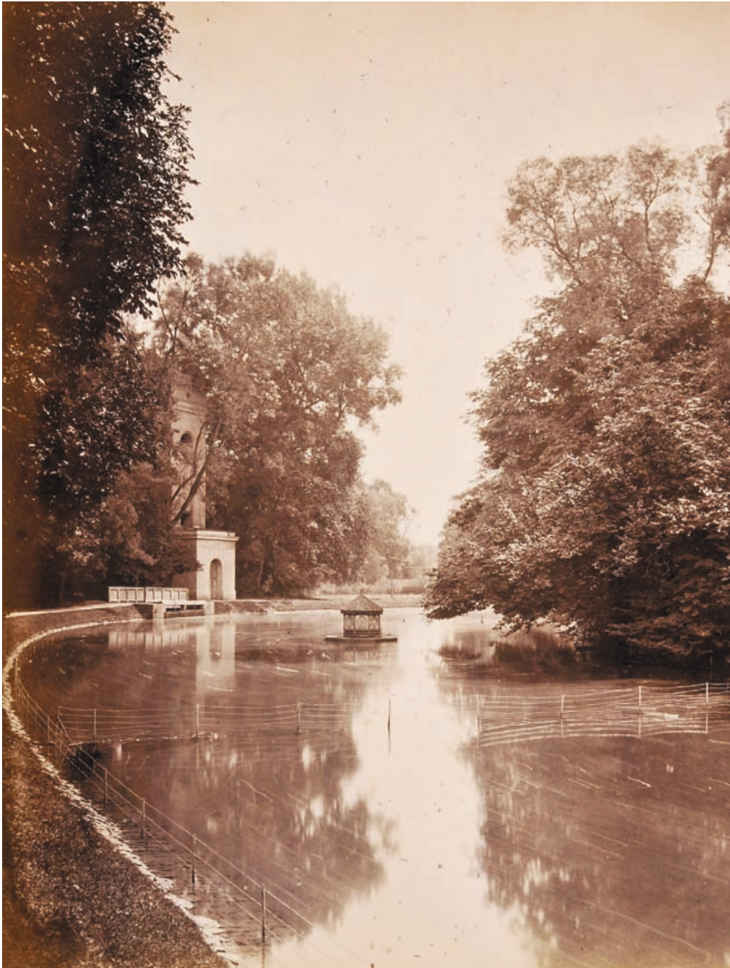
Wasserturm am Schwanenweiher (Situation etwa 1860).
