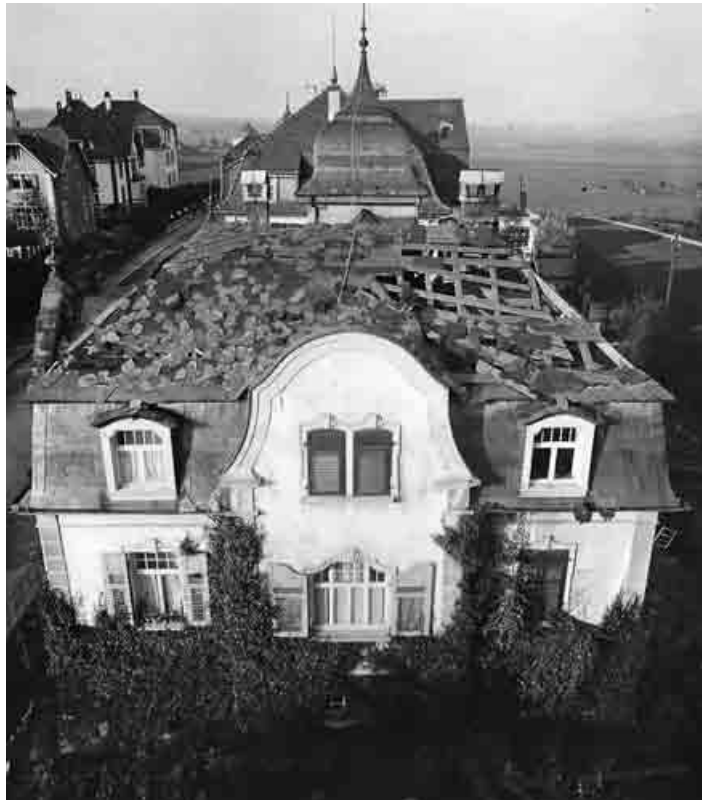
Blick auf das am 12. Oktober 1916 von einem Bomben- treffer beschädigte Dach des Hauses Moltkestraße 10 in Donaueschingen. Foto: Archiv W. Hönle
