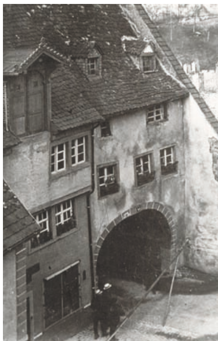
Das alte Mailänder Tor unmittelbar nach dem Stadtbrand von 1921. Stangen sollen den Einsturz des Giebels verhindern.
